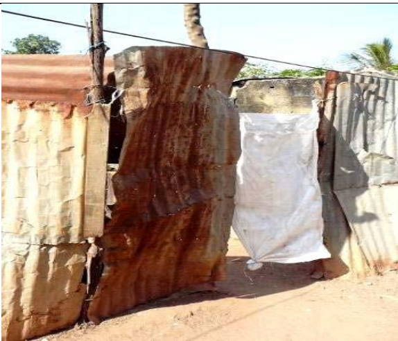
Latrines à simple trou les plus précaires (source PECHER/EDE)
