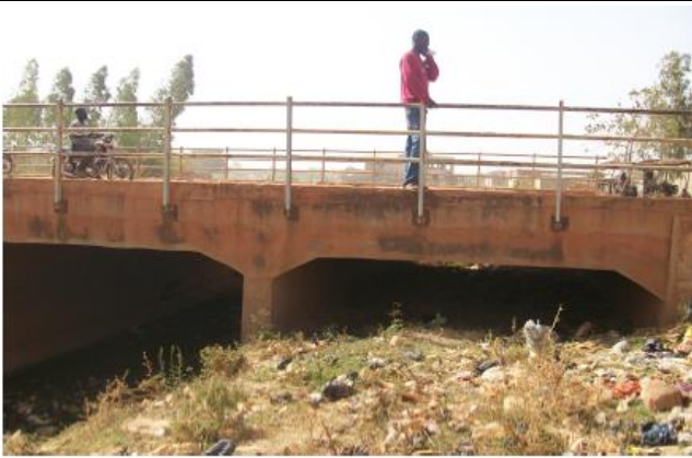
Exemples de situations affrontées : obstruction de rives sur dalot, constructions existantes sur l'emprise du canal
