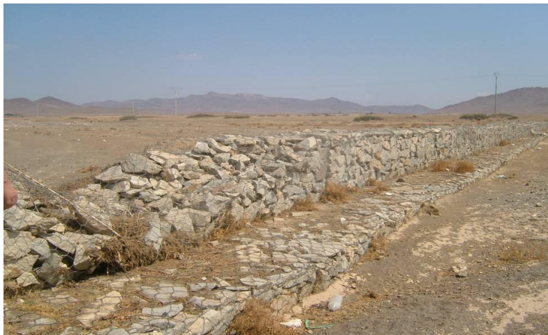
Seuil en gabion
