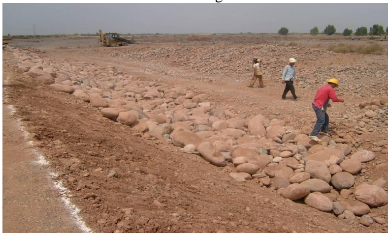
Traitement des berges
